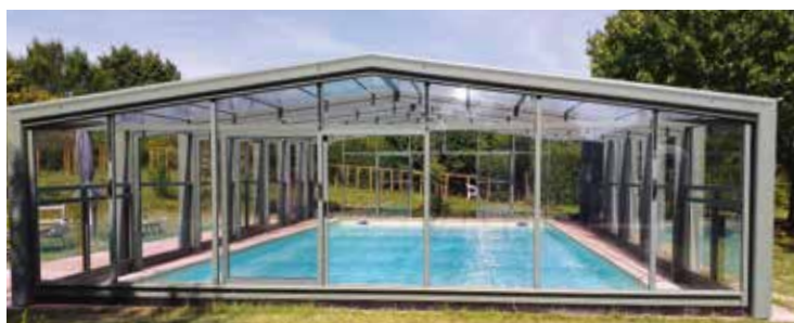
VISTA FRONTALE, CON PISCINA COPERTA
