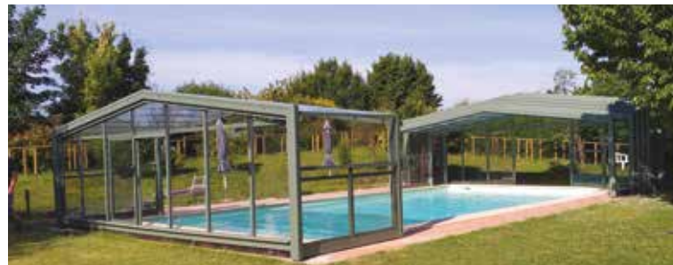
PRIMO ARCO FISSO E IL RESTO DEI MODULI IMPACCHETTATI
