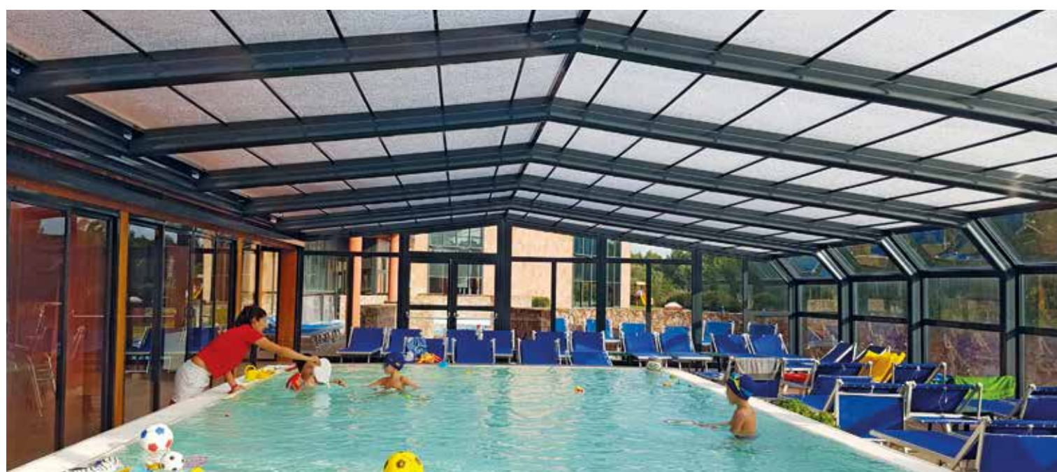
LA COPERTURA ADDOSSATA IN DOPPIA PENDENZA, PERMETTE DI RAGGIUNGERE LARGHEZZE SUPERIORI AI 12 METRI
